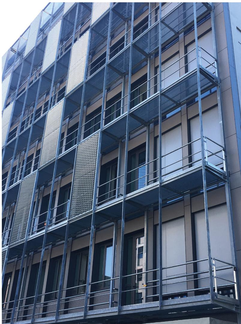
Les passerelles de liaison avec le bâtiment Lippmann sont reconstruites en charpente métallique habillée de bardage métal après réalisation de l'extension.
