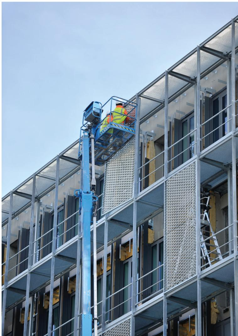
Les passerelles de liaison avec le bâtiment Lippmann sont reconstruites en charpente métallique habillée de bardage métal après réalisation de l'extension.
